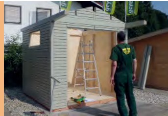
Einsetzen der fertig montierten Wand- und Giebelelemente
