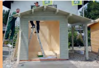
Erstellung der Dachschalung
