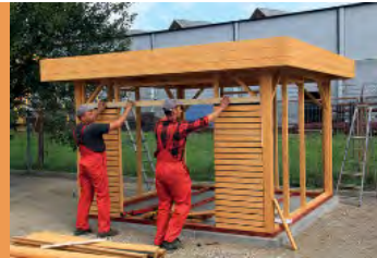
Anbringen der Rhombusschalung
