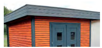
Flachdach (mit Dachüberstand)
