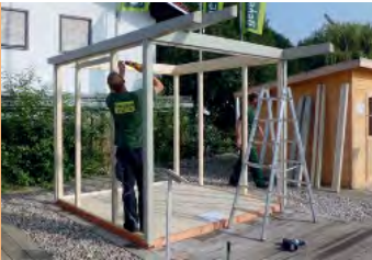
Aufbau der Skelettstruktur
