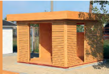
Dach- und Wandschalung
